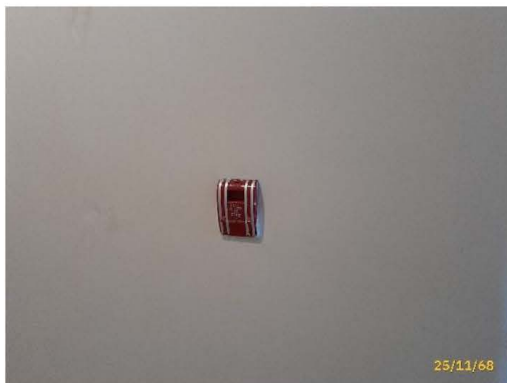
อุปกรณ์แจ้งเหตุเพลิงไหม้แบบกด
