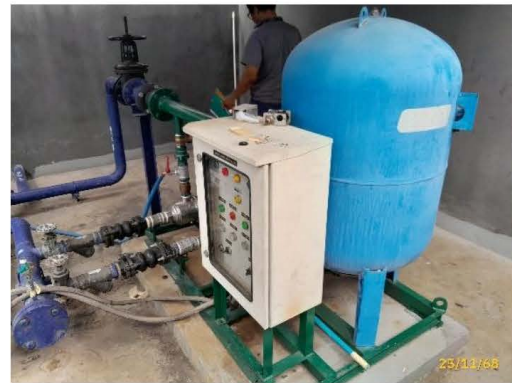
เครื่องสูบน้ำเสริมแรงดัน
